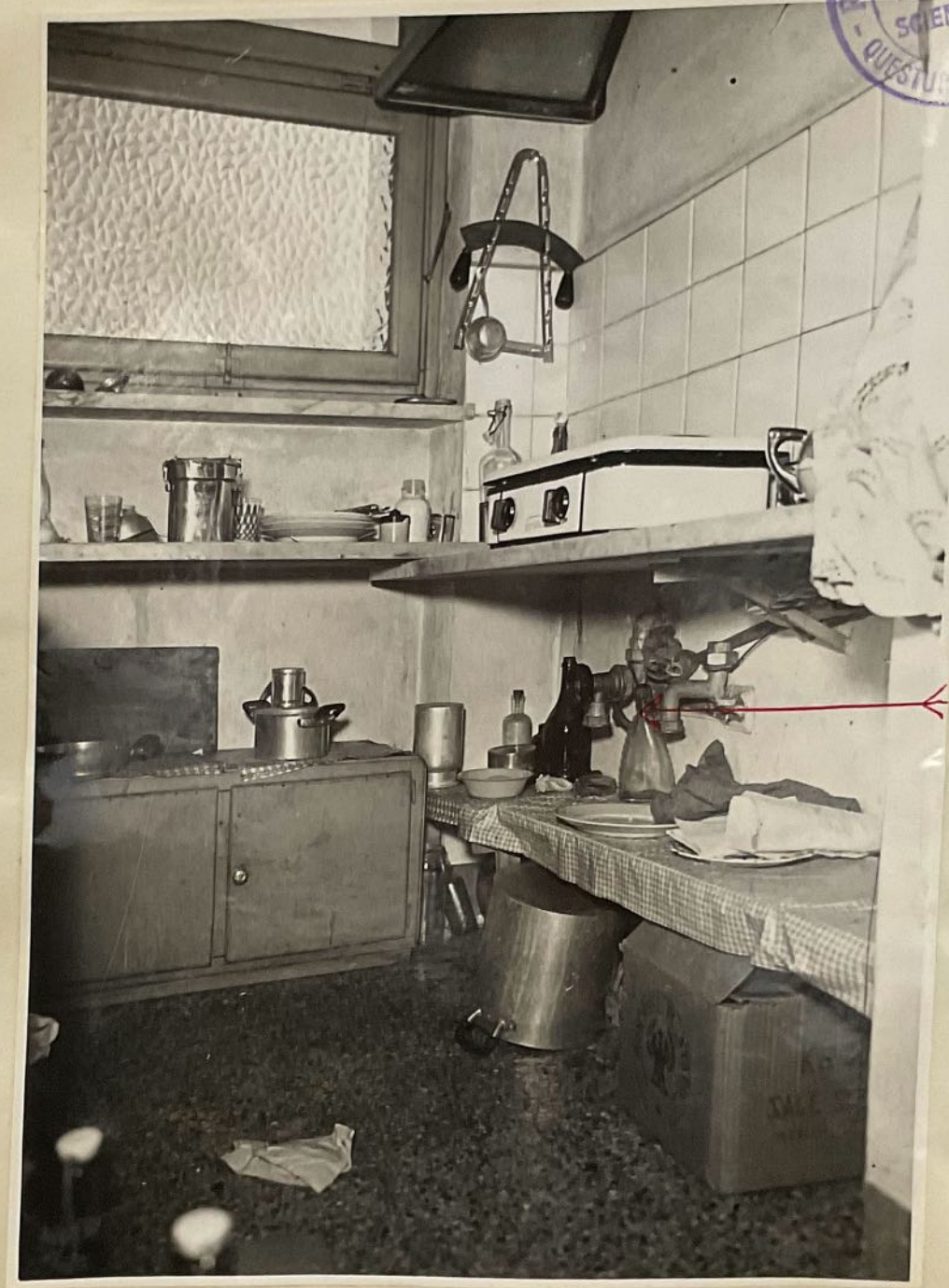
Figura n°8 - Particolare per mettere in evidenza il bocchettone della presa del gas e relativa manopola priva del conta e del piombino fissato dalla società gazometro.-
