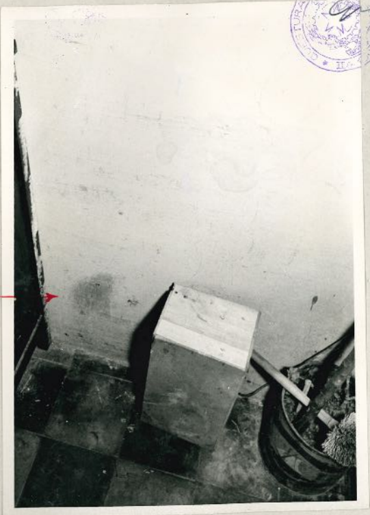
Ril.n°II- Particolare di macchia rossastra sulla parete sinistra del gabinetto -
